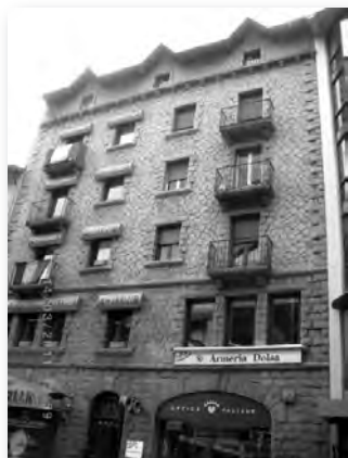
Façana actual de l'edifici a l'avinguda Meritxell núm. 22, on va residir Josep Fontbernat i Verdguer
